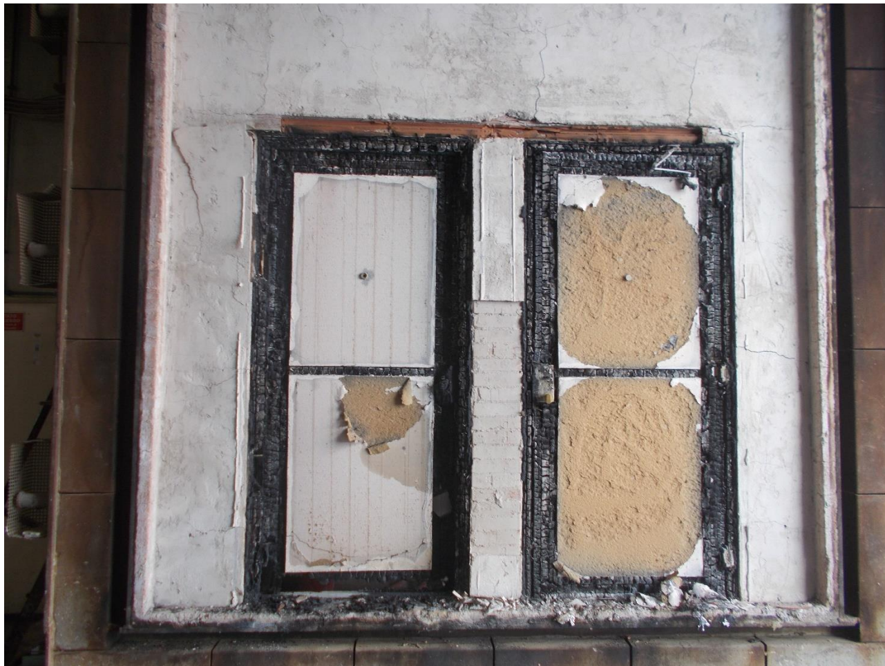
Fig. 2 La faccia esposta del campione dopo la prova Fig. 2 Exposed face of test specimen upon completion of test
